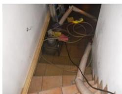
Wir wurden in die Schlossgasse zu einem Wassergebrechen alarmiert. Ein Keller stand ca. 80 cm tief (80m<sup>3</sup> Wasser) unter Wasser. Mittels zwei Tauchpumpen fingen wir an das Wasser aus dem Keller hinaus zu pumpen. Mit einem Nasssauger der FF Klein Wolkersdorf wurde das Restwasser aufgesaugt.
